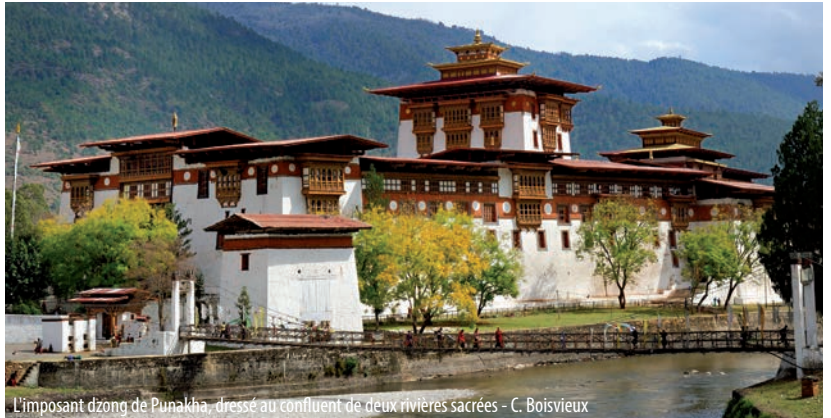
L'imposant dzong de Punakha, dressé au confluent de deux rivières sacrées - C. Boisvieux
