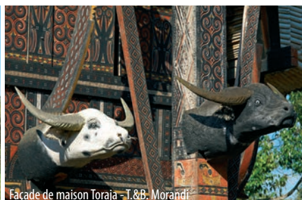
Façade de maison Toraja - T.&B. Morandi
